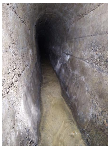
Figure 44 : Réseau Assainissement ovoïde 1 300 mm - Avenue Baudin
